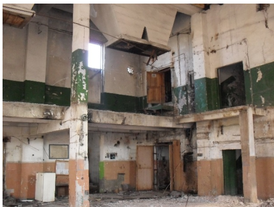
Подготовительный участок до реконструкции
