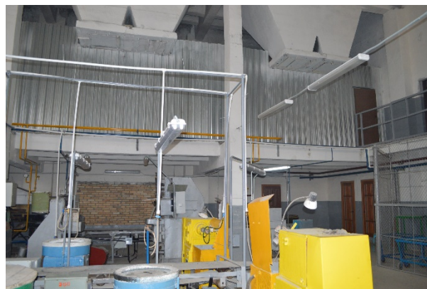
Подготовительный участок после реконструкции
